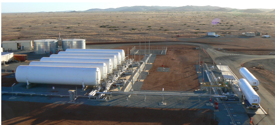
LNG plant near Karratha
