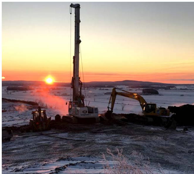
Centrale électrique Lidya Energie
